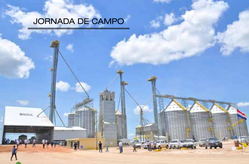
Nuevo silo de acopio.
