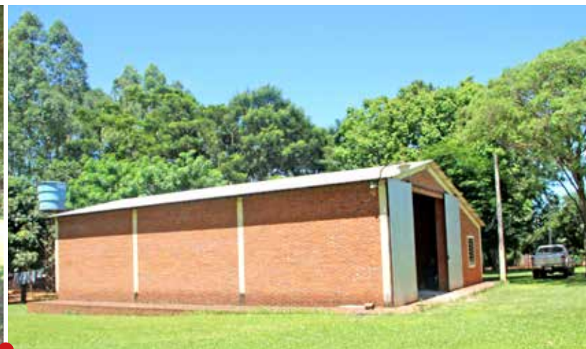
Vistas del Centro Comunitario San Antonio Cocuerá.
