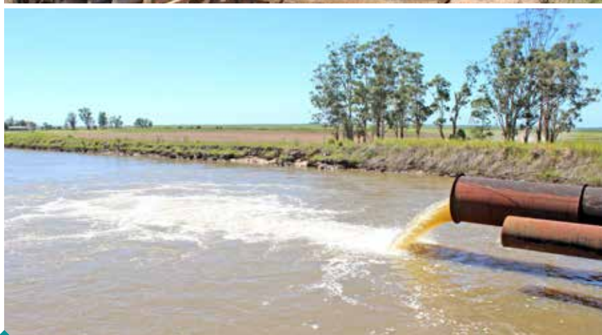
Reservorios de agua en el establecimiento.
